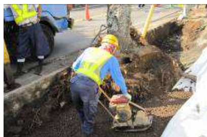
根系誘導耐圧基盤は一層23～24cm蒔き出し→振動プレートにて転圧後20cmに施工します。
