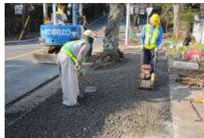
路盤は舗装工同様の転圧。その後、舗装を行い施工終了となります。
