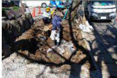
路床部分には樹木の根が多く存在しているので、根を傷付けない様、注意して掘削。細根が多い場合は、エアースコップ※を使用します。
