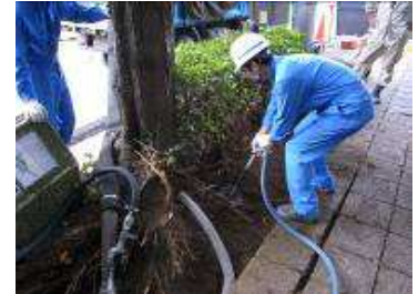
※エアースコップ 根を傷つせず、風圧によって土を掘削していく工法です。
