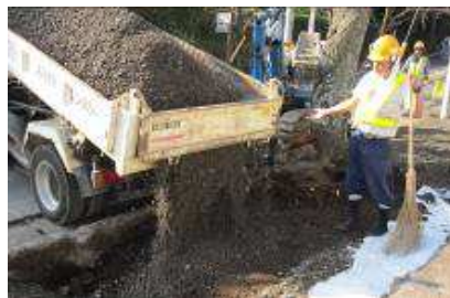
根系誘導耐圧基盤の上に路盤を撒き出します。
